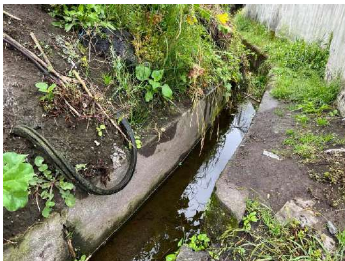
Ilustración 11. Tipo de Canal de Riego Hormigón
